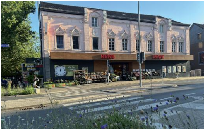
Der bisherige Rewe-Standort in Mark soll überbaut werden.
