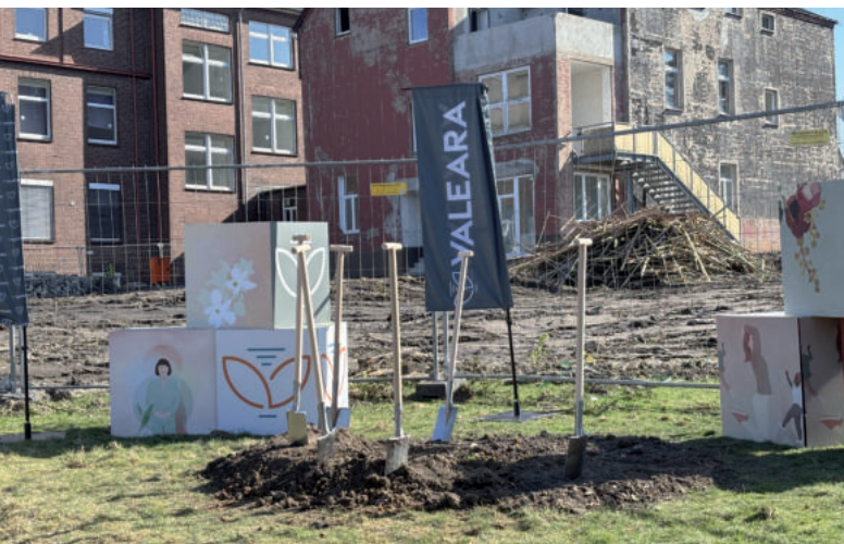
Der Spatenstich für den Valeara-Neubau fand vor der verlassenen St.-Josefs-Klinik statt.
