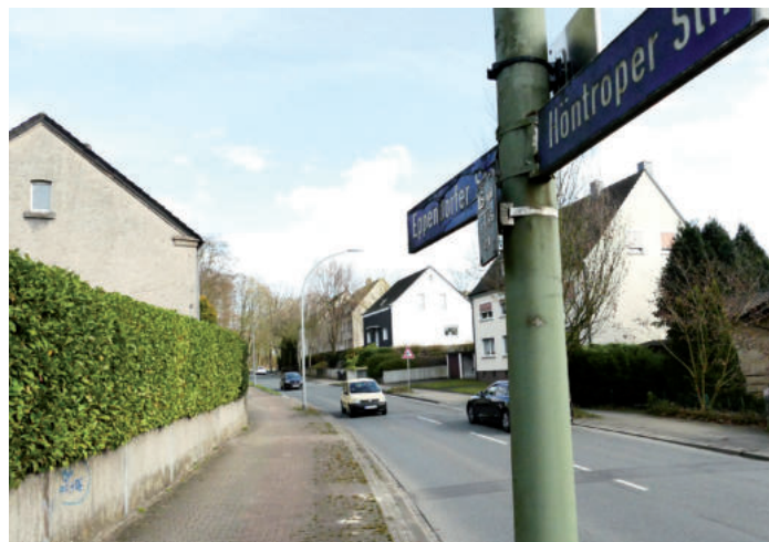
Die Eppendorfer Straße wird für zweieinhalb Jahre zur Baustelle.
