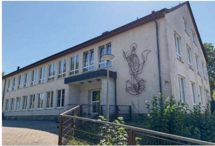
Wird barrierefrei: Das Gemeindezentrum an der Brenscheder Straße.
