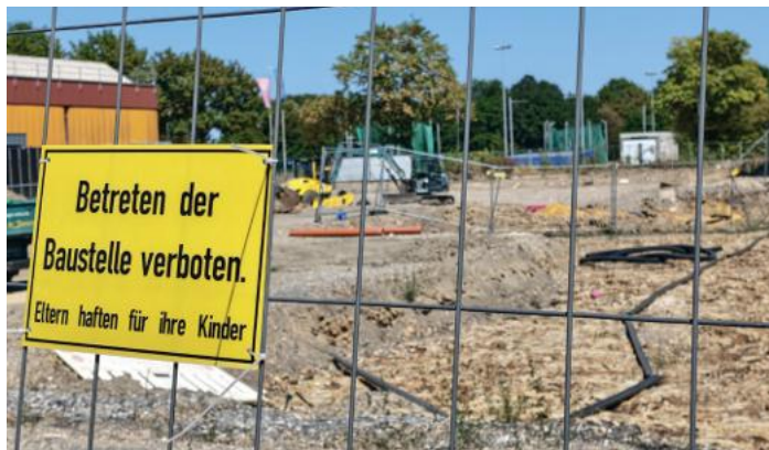
Die Arbeiten haben begonnen.
