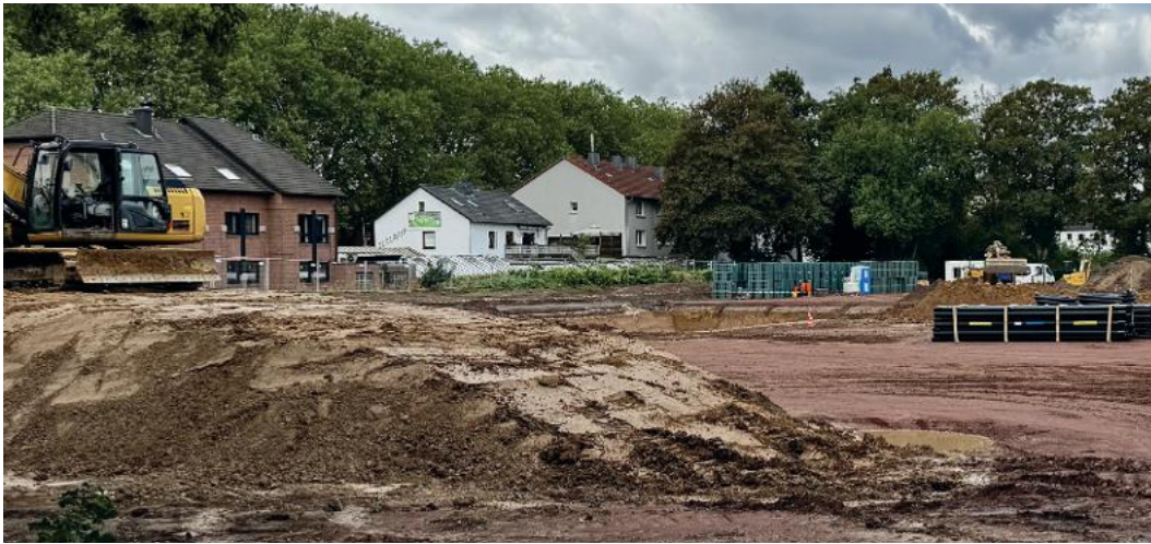
Auf der Baustelle herrscht reger Betrieb.
