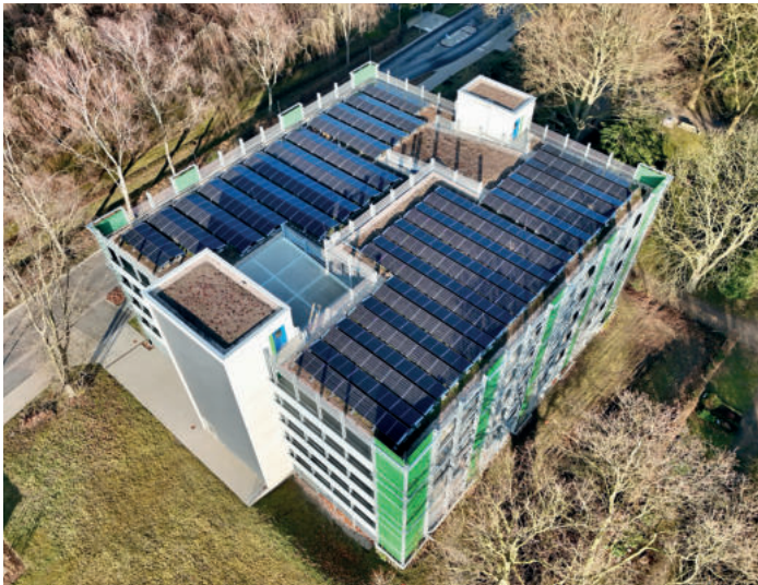
Solarmodule: Erstmals auf dem Dach eines Parkhauses.
