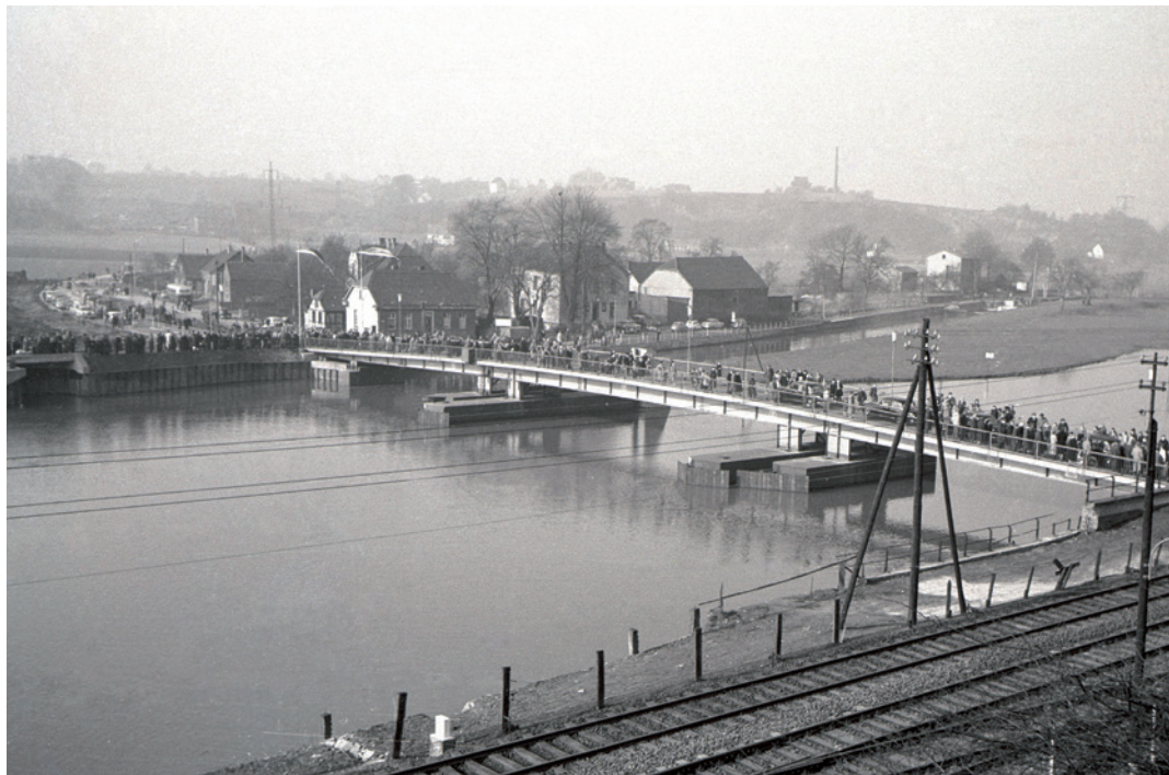
Die Alt-Brücke in Dahlhausen um 1930 und heute (unten).
