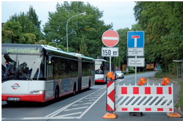
Noch bis Mitte November wird gebaut.
