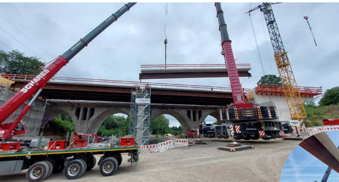
Riesige Stahlträger wurden in den Brückenneubau gewuchtet.
