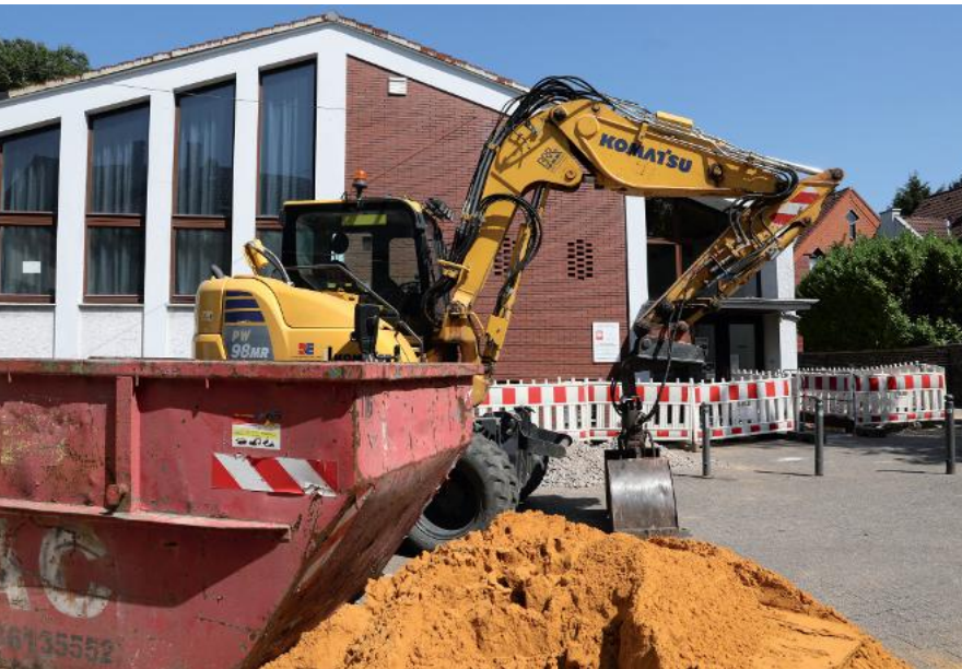
Das Gemeindeheim St. Franziskus wird umfangreich umgebaut.
